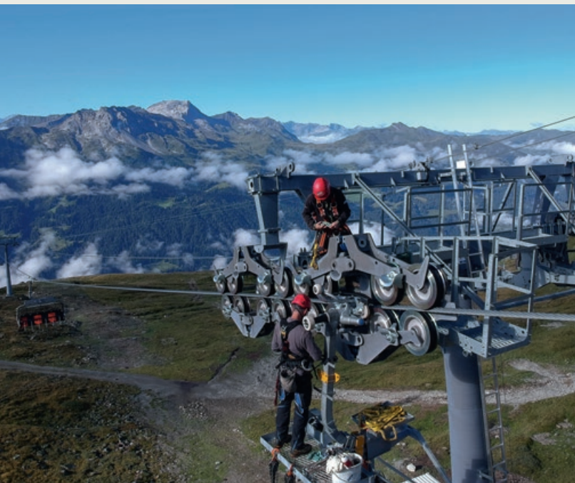
Revisionsarbeiten, © Klosters-Madrisa Bergbahnen AG
