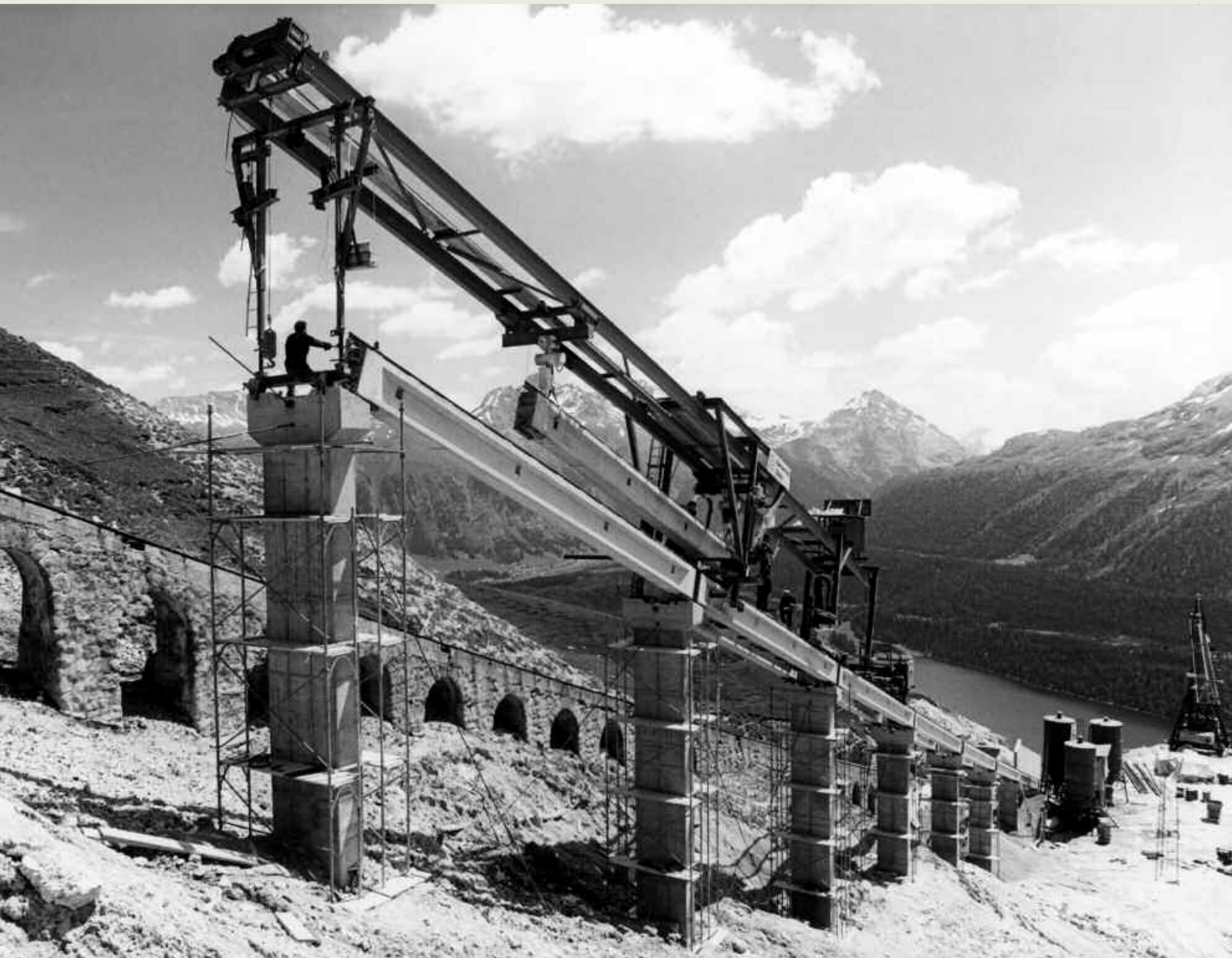
Bau Trasse Corviglia-Bahn, 1985, © Dokumentationsbibliothek St. Moritz, Urheber unbekannt
