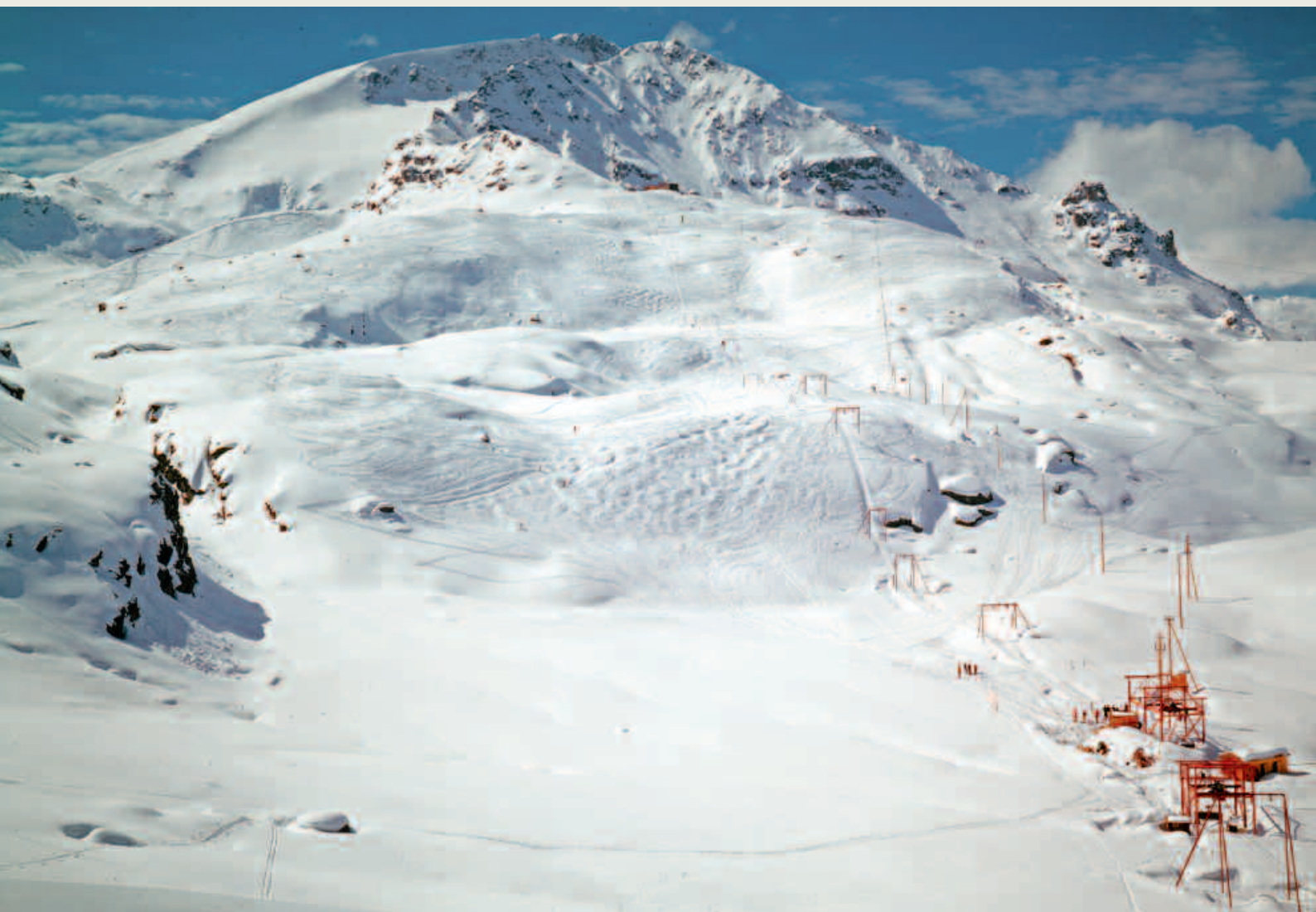
Mandras Lift, Corvatsch, ca. 1970, © Dokumentationsbibliothek St. Moritz, Hans Steiner
