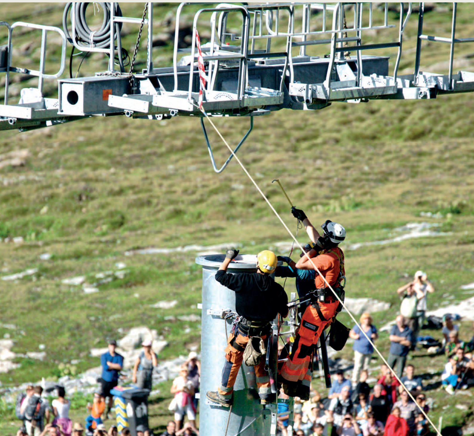
Montage der Masten bei der neuen 10er Gondelbahn Alp Sogn Martin - La Siala, © Weisse Arena Gruppe, Laax
