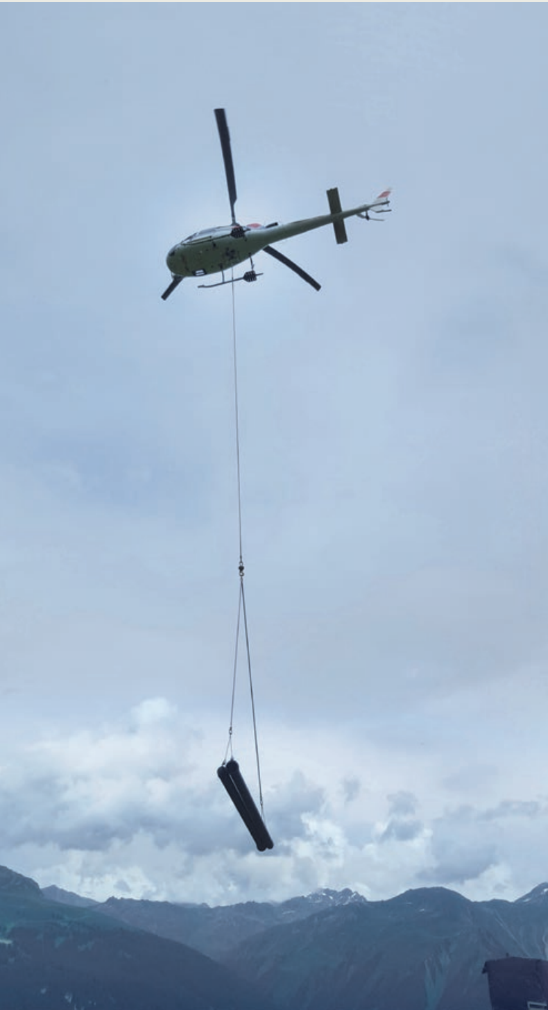
© Davos Klosters Bergbahnen AG; Helitransport Leitungs- rohre für Beschneigung
