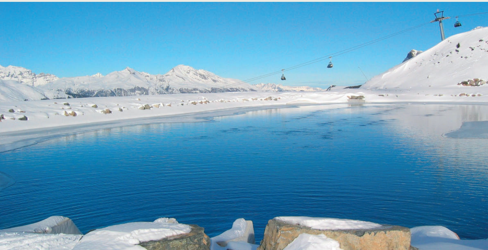
Speichersee Scharmoin (50'000 m 3 ), Lenzerheide Bergbahnen AG
